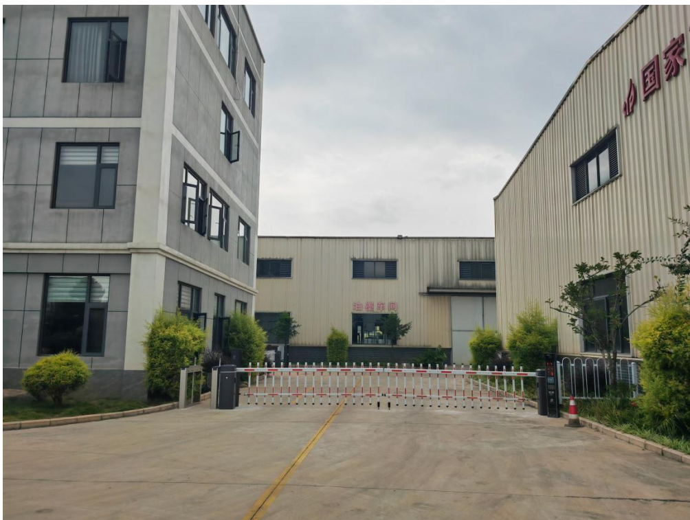
图 2-6 厂区门禁系统
