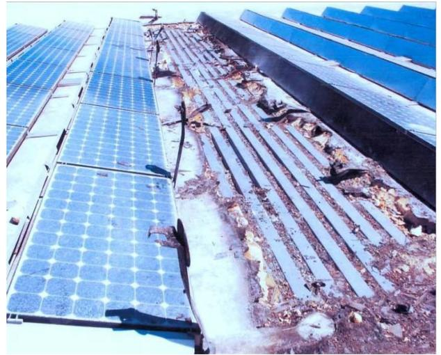
图 3-2 屋顶太阳能光伏电站“自燃”现场
