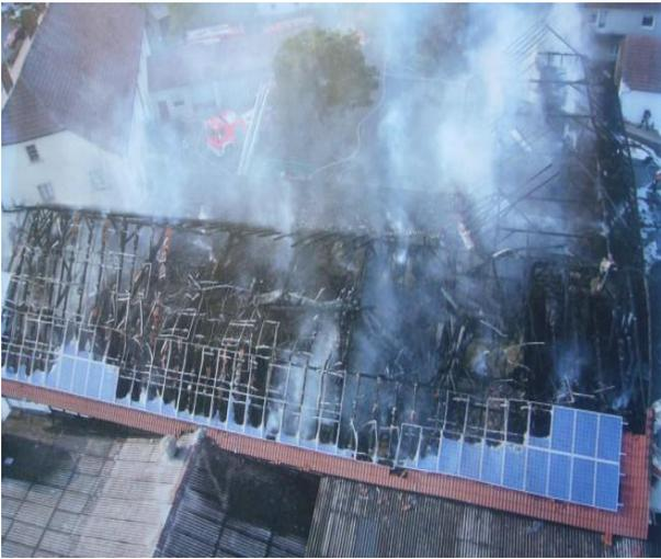
图 3-1 光伏屋顶的太阳能组件“自燃”
